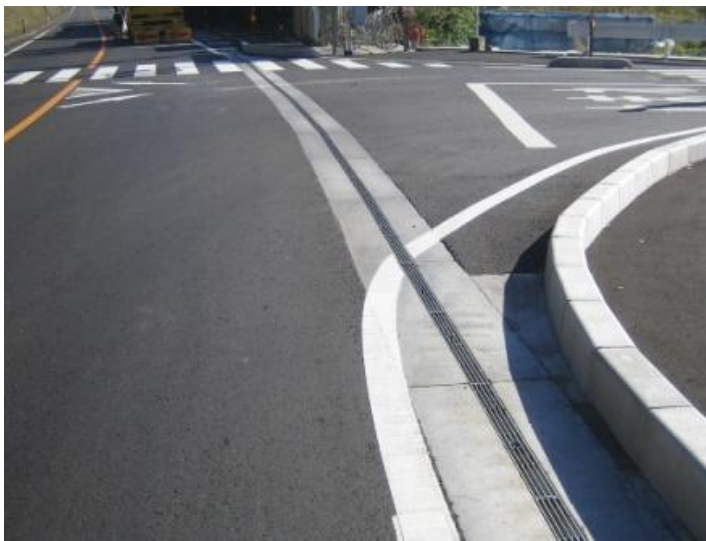
国道29号現場 /国土交通省 鳥取河川国道事務所 発注
