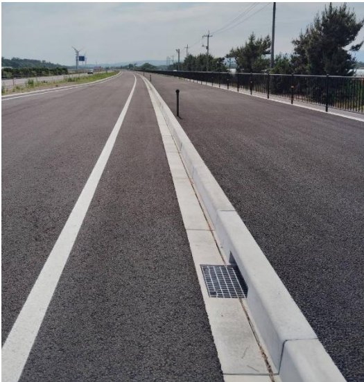
北条道路現場 /国土交通省 発注
