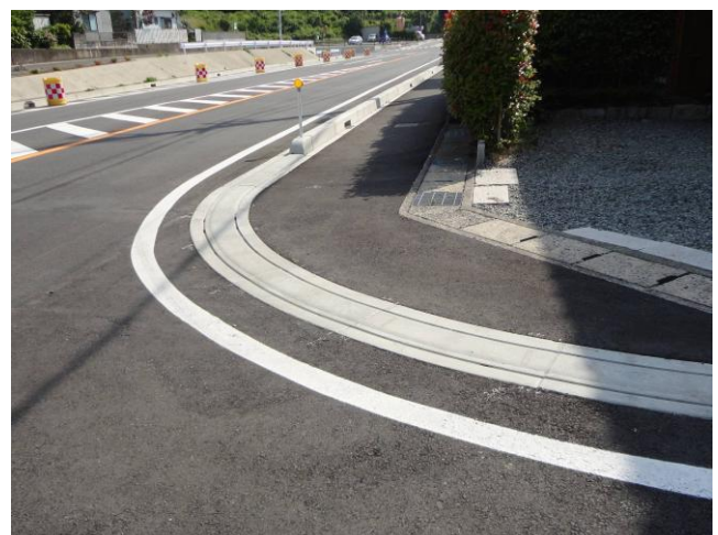
街路滝山桜谷線現場 / 鳥取県土整備局発注
