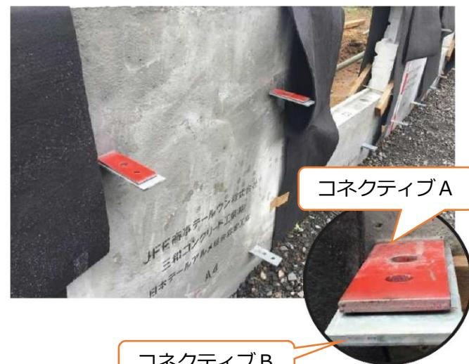
壁面材の前傾・段差を検知
