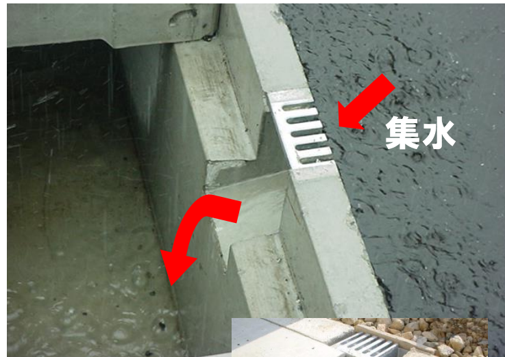
後付け排水ドレン金具 施工後 ▶
