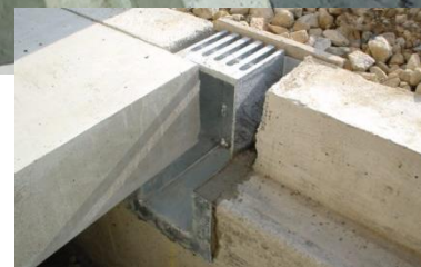
後付け排水ドレン金具 施工後 ▶
