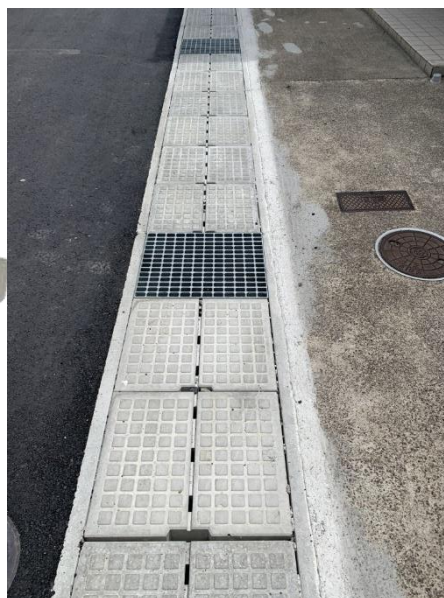
鳥取市/(浸水)第43工区下水道工事
