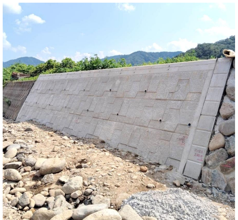
私都川(延命寺工区)河川災害関連工事(5年災 229号及び230号)(4工区)
