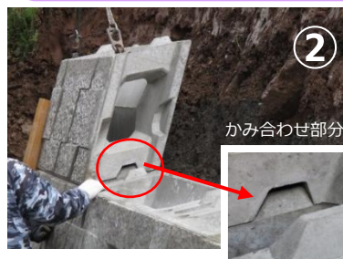
② 据付け ※製品同士がかみ合うように据付け
