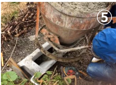
⑤ 間詰めコンクリートをブロックの半分程度の高さまで打設 ②～⑤までを繰り返します
