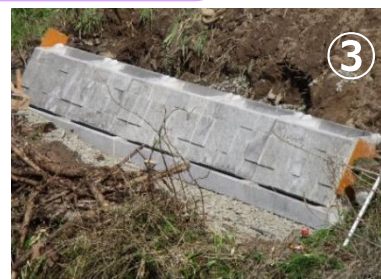
③ 1 段目据付け完了
