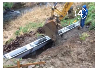
④ ブロックの裏側を埋戻し
