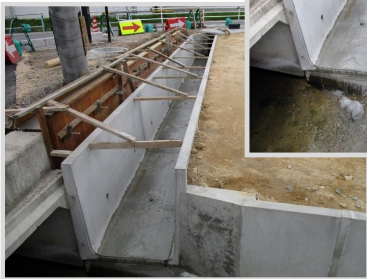
既設の水路に合流するように施工されました。
