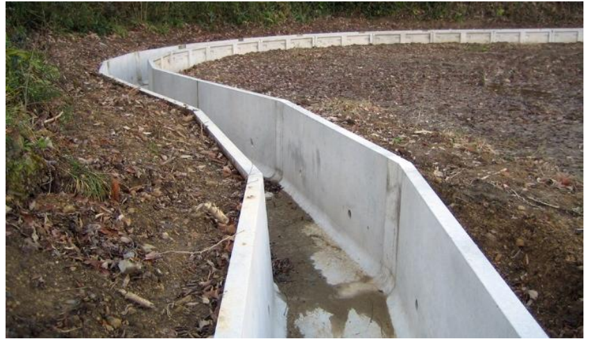
▲R部は製品の間現場打ちコンクリートを施工し、角度をつけています。
