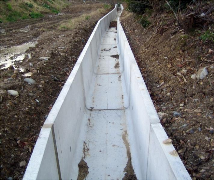
▲R部は製品の間現場打ちコンクリートを施工し、角度をつけています。
