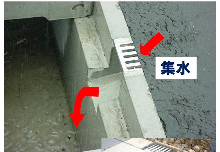
後付け排水ドレン金具 施工後
