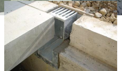
後付け排水ドレン金具 施工後
