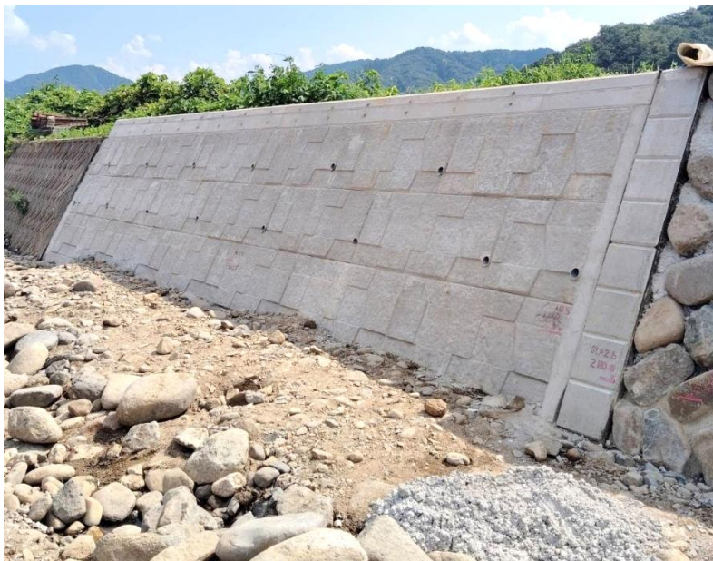
私都川(延命寺工区)河川災害関連工事(5年災229号及び230号)(4工区)
