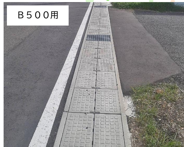
▼倉吉市/令和4年度市道和田東町井手畑線側溝改良工事
