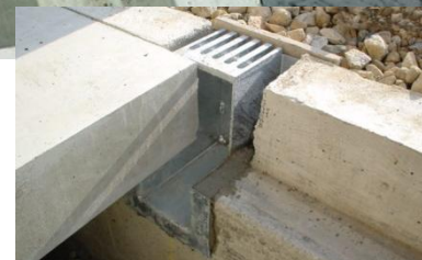
後付け排水ドレン金具 施工後
