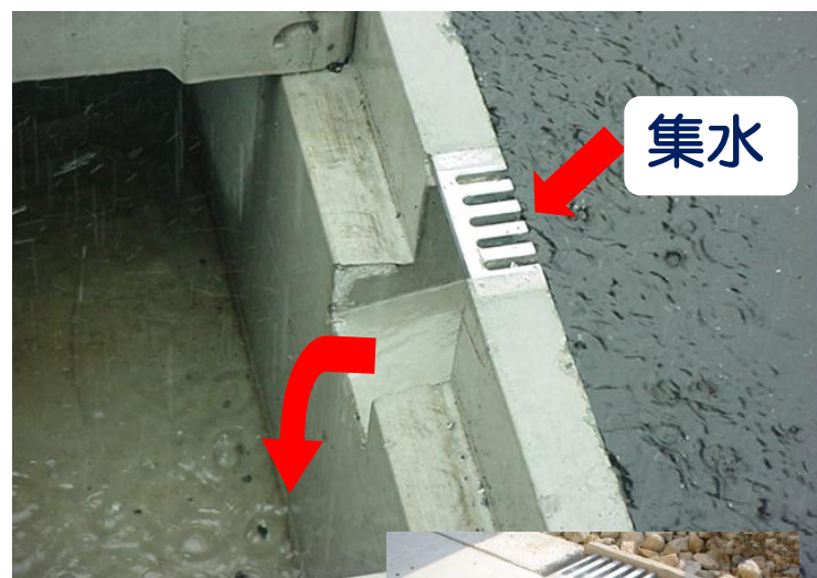
後付け排水ドレン金具 施工後
