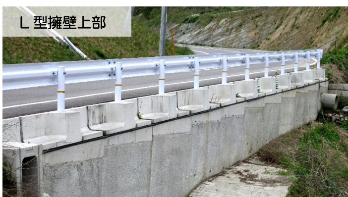
大型ブロック上部(NSSブロック)
